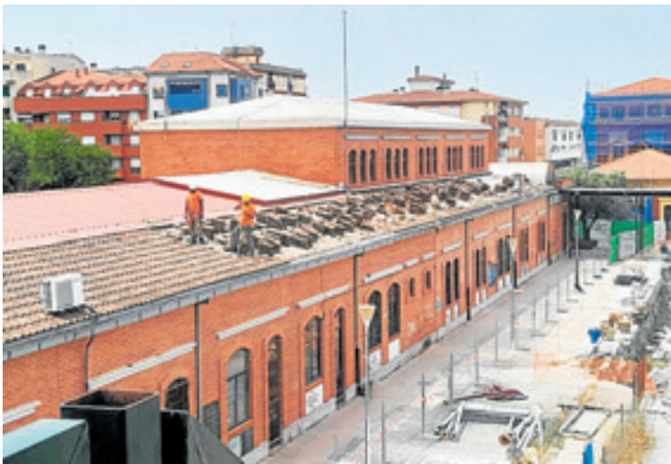
Las obras han comenzado con la reparación de la cubierta. M.A.M.
