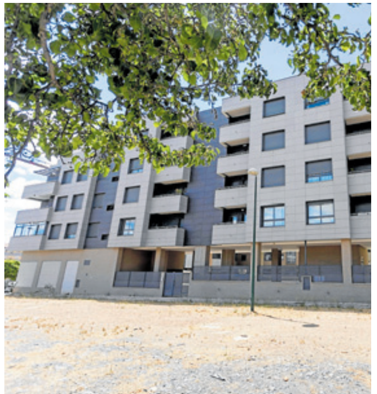
Edificio finalizado en Casa Plata tras paralizarse en la crisis del ladrillo. J. REY
